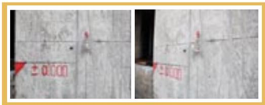
4.2 到±0.000后，结构层每增加一层，测量一次，直到结构封顶。在装饰阶段，每两个月测量一次，直到工程竣工。工程竣工后，第一年，每季度测量一次，第二年测量两次，第三年后每年测量一次，直到沉降稳定为止。
