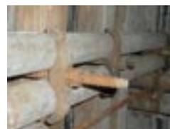
图12 剪力墙端头可调节螺杆与双钢管拧紧
