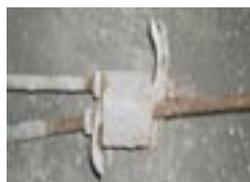
图11 螺杆穿在短钢管上
