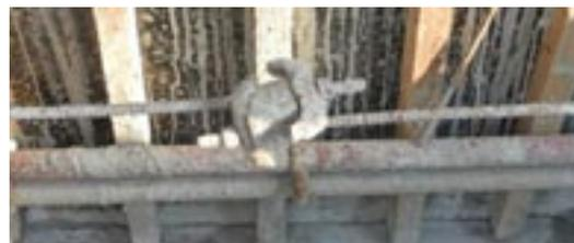
图13 连接完成的可调节螺杆
