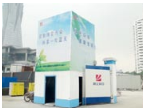
7、水泥桶用废旧模板拼接围护，涂刷白色油漆，上部做彩色喷绘布。
