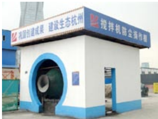
7、水泥桶用废旧模板拼接围护，涂刷白色油漆，上部做彩色喷绘布。
