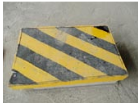
8、1.5m 2 内预留洞口用废旧模板涂刷黄黑相间警示漆封盖。
