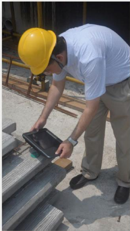
构件进场检查
