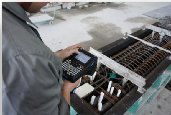
钢筋入模浇筑前检查确认
