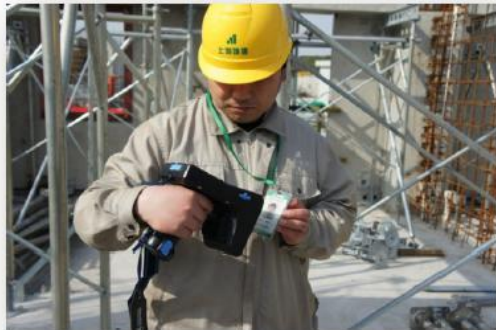
现场安装人员登录
