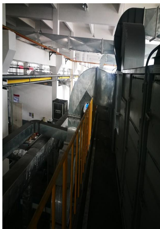
喷涂废气处理设施
