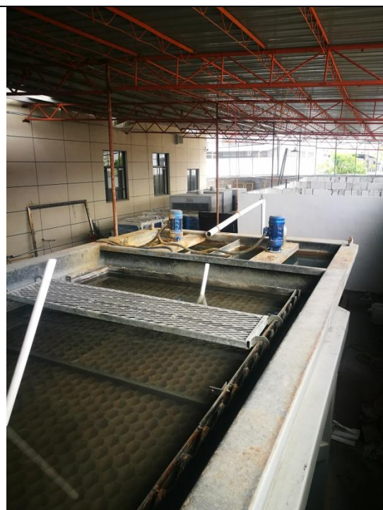
废水处理设施
