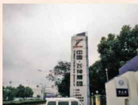
改造前东门顶棚
